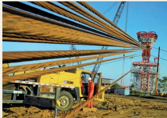
架设六个方向的缆风绳系统，确保门式起重机电稳定运行 梁海军摄
