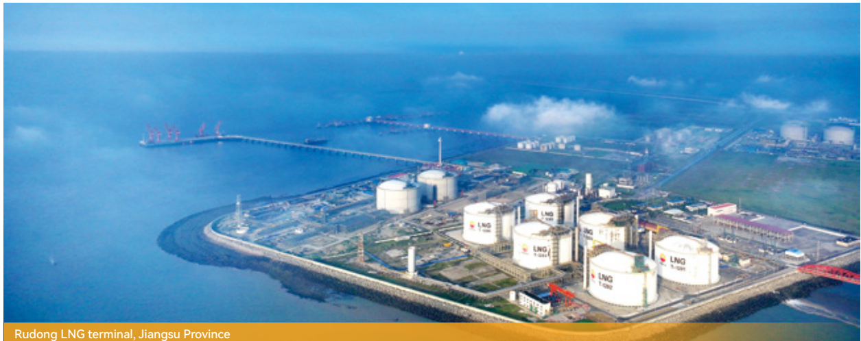
Rudong LNG terminal, Jiangsu Province
