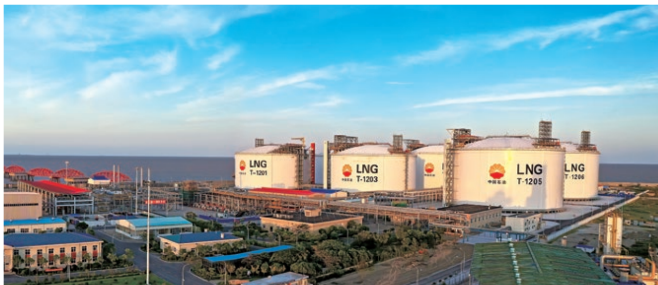
Jiangsu LNG Terminal
