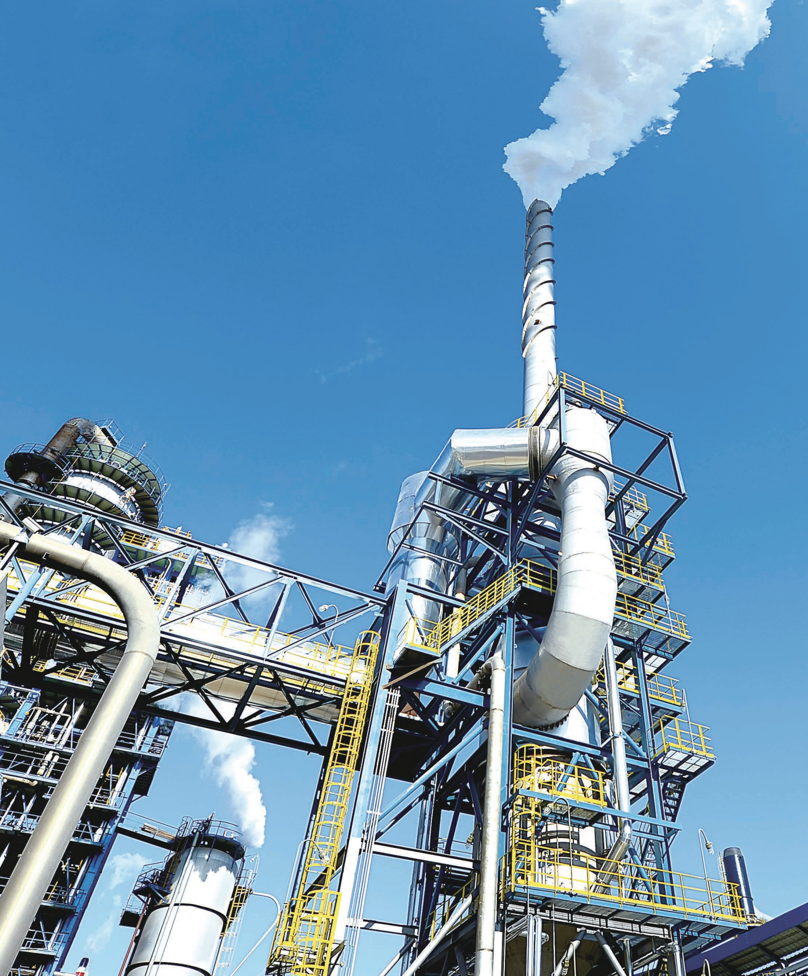
Установка по очистке дымовых газов в компании Jinxi Petrochemical
