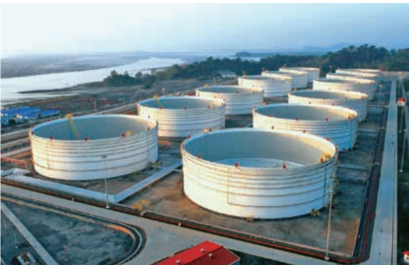
La construction du réservoir à essence à l'île Maday au Myanmar
