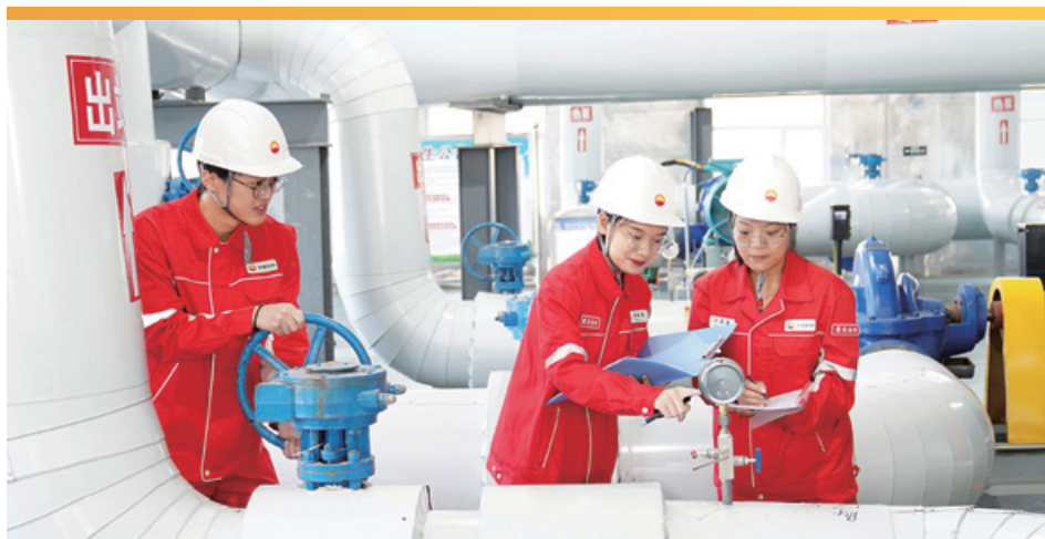
▲ 查看地热设备运行情况
