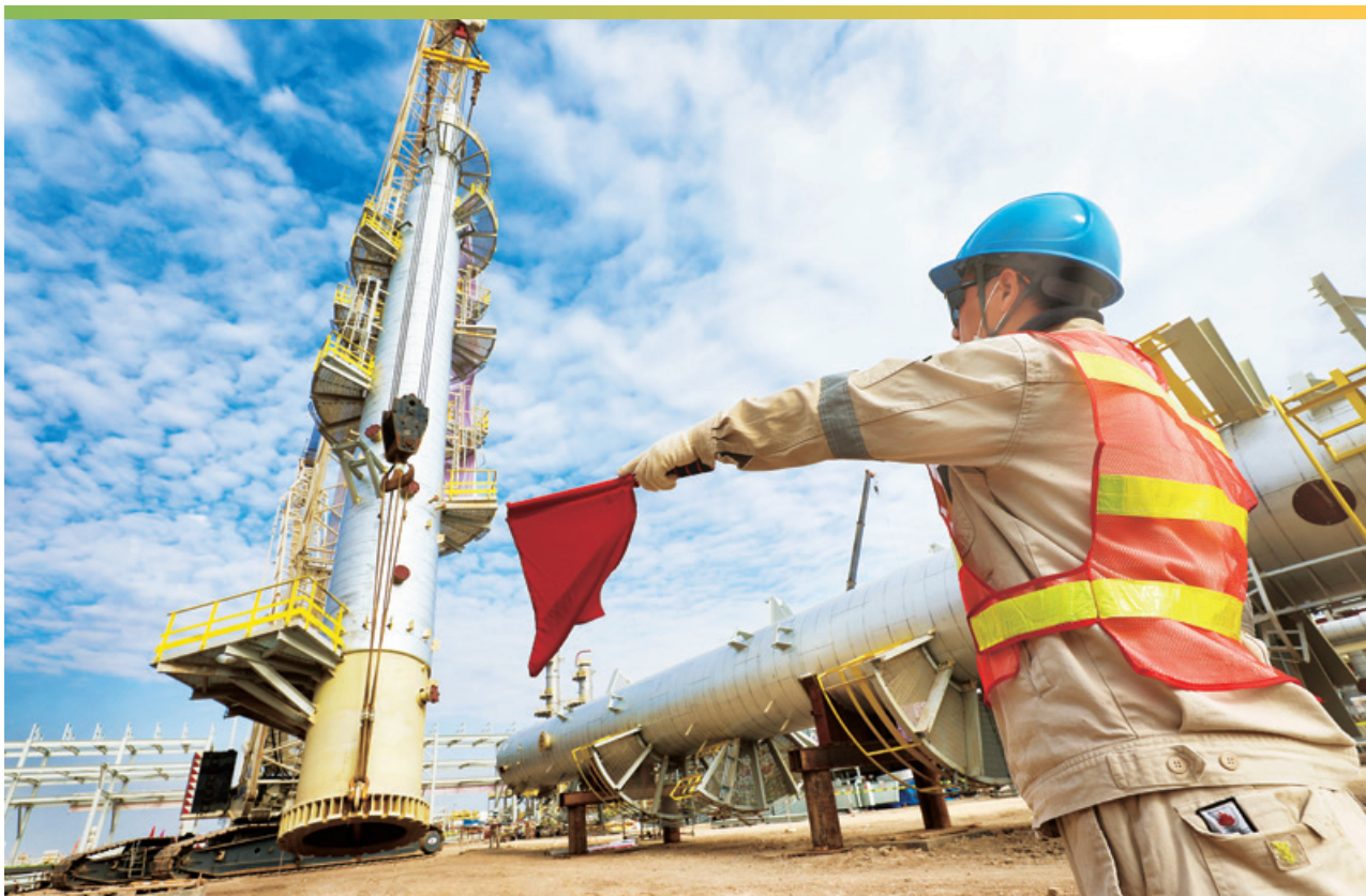
▲ 安全守护下的塔器吊装
