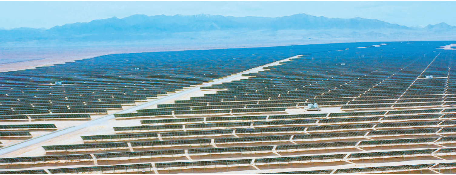
✓ 玉门油田30万千瓦光伏发电示范项目并网发电
