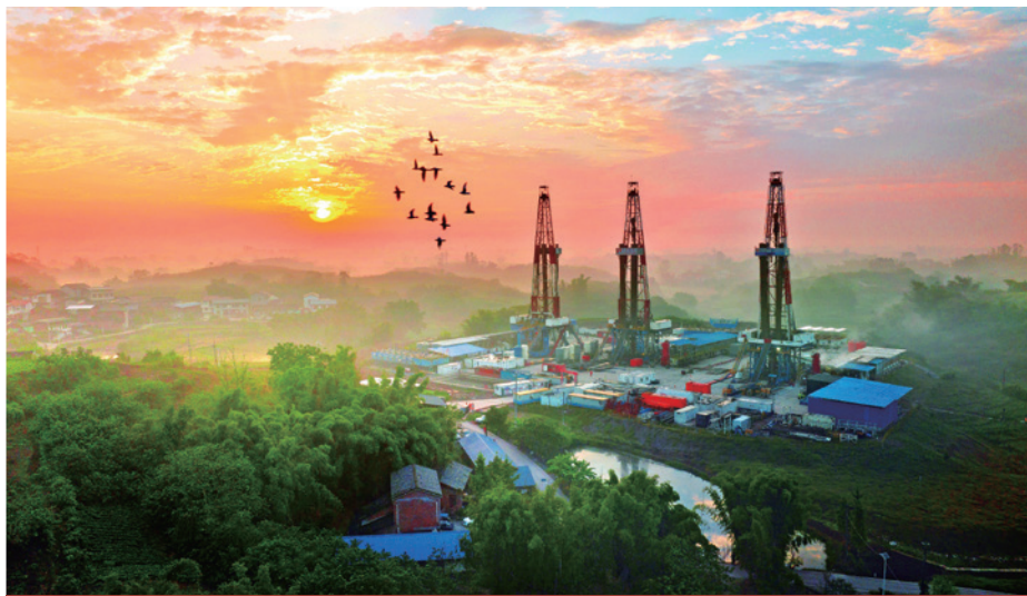
西南油气田川南自205H92平台钻井作业现场
