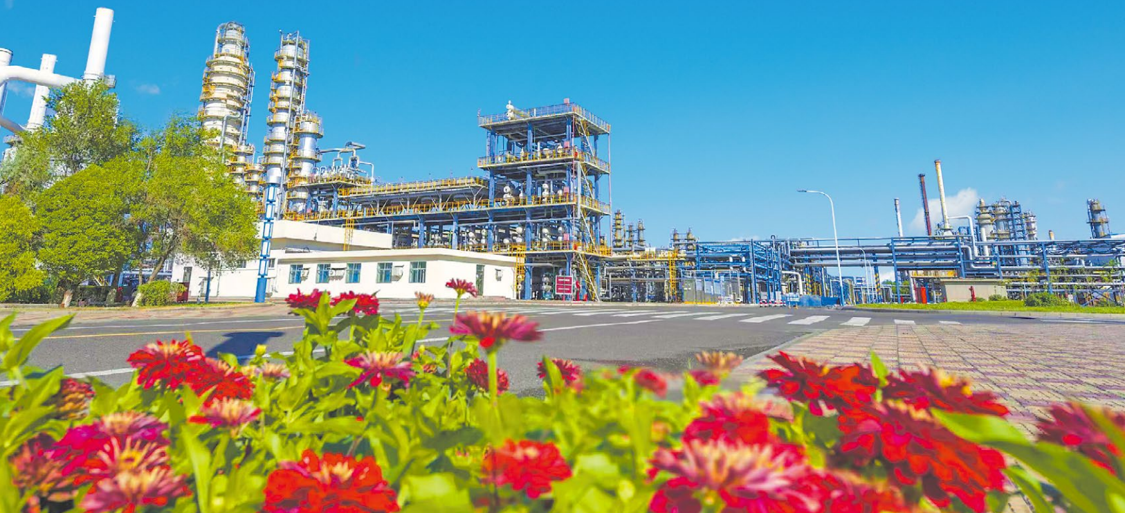
克拉玛依石化公司厂区
