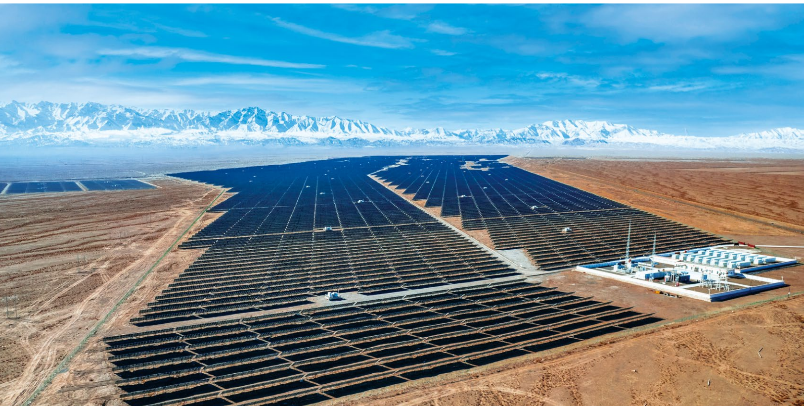
玉门油田光伏发电项目
