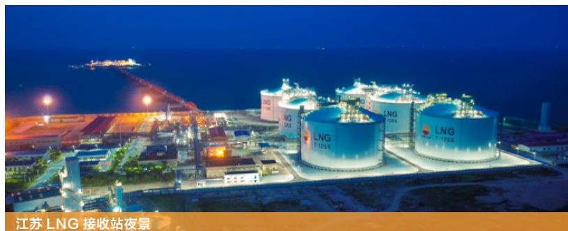
江苏 LNG 接收站夜景
