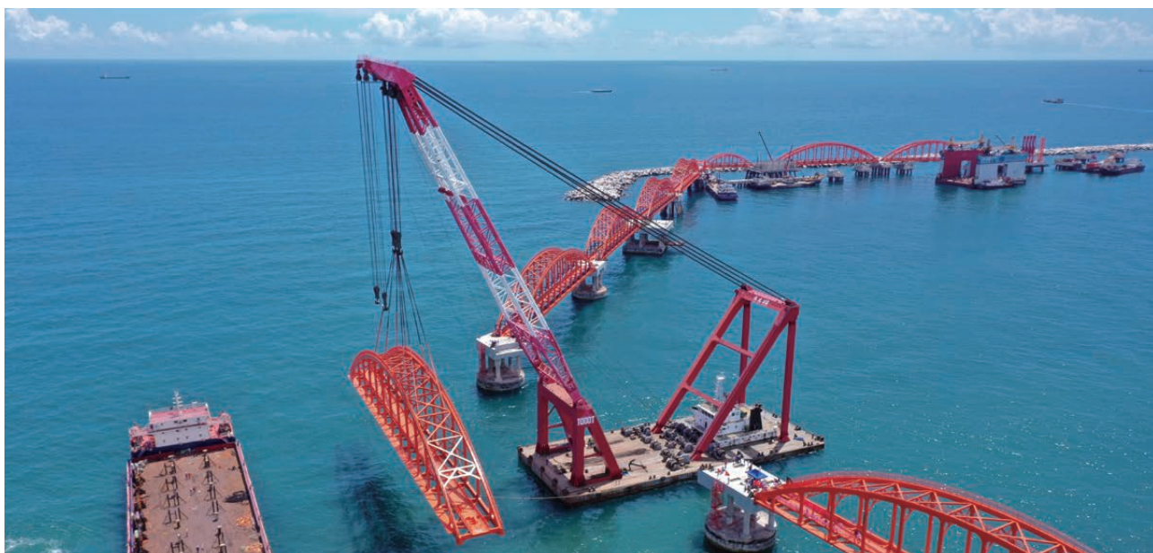
广东石化炼化一体化项目原油码头施工现场
