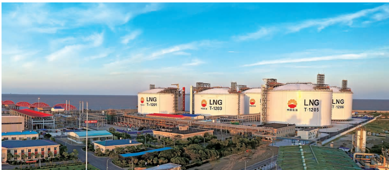
江苏 LNG 接收站
