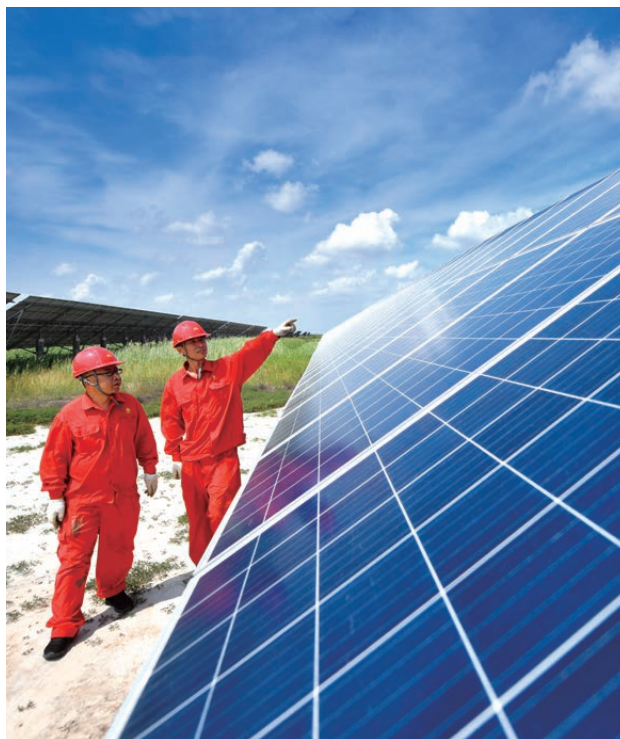
吉林油田光伏发电项目
