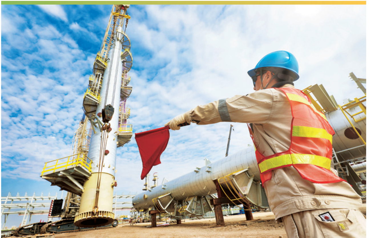
▲ 安全守护下的塔器吊装
