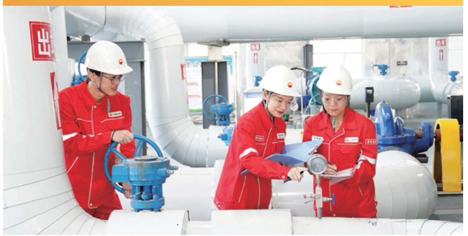
▲ 查看地热设备运行情况
