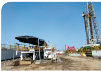
泥浆不落地现场
