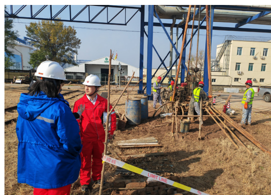
辽阳石化土壤污染调查现场
