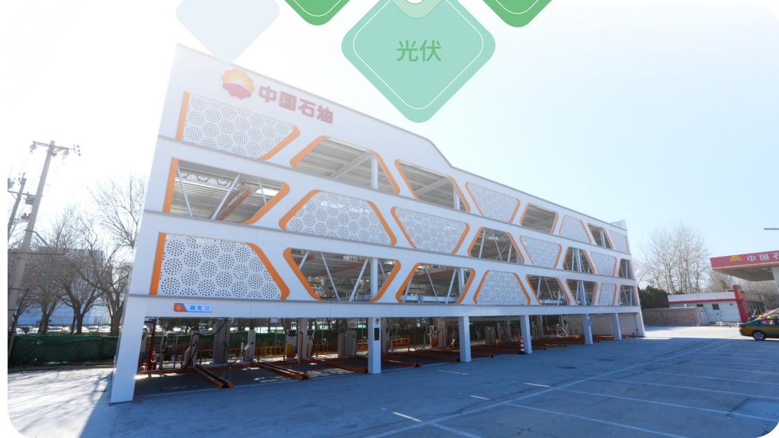
北京望京南加油站充电站
