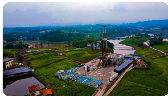
大坝 1 井钻机油改电现场
