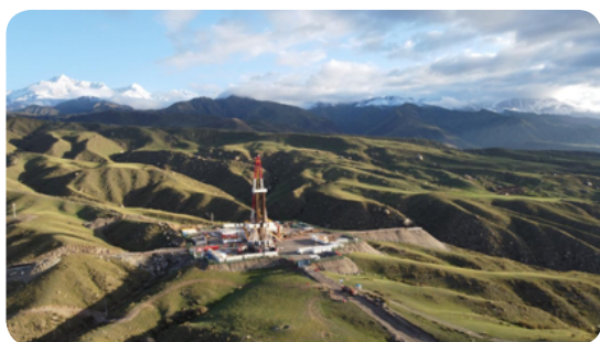
宿探 1 井钻机油改电现场
