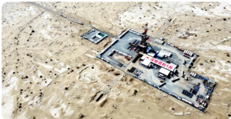
深地塔科 1 井钻机油改电现场
