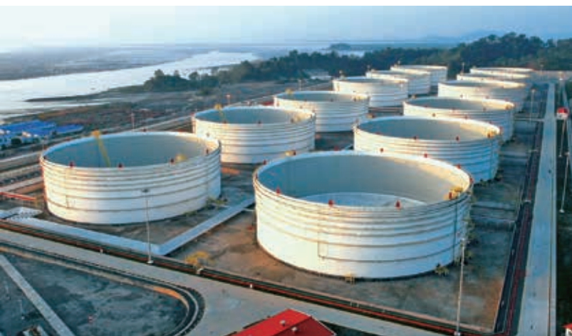
Строительство нефтехранилища на острове Madau в Мьянме
