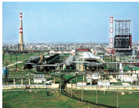
ходе модернизационного строительства НПЗ будет выполняться перевооружение для всего оборудования, в т.ч. монтаж дополнительных установок каталитического крекинга и риформинга гудрона, создание оборудования изомеризации и каталитического гидрокрекинга и т.д.
