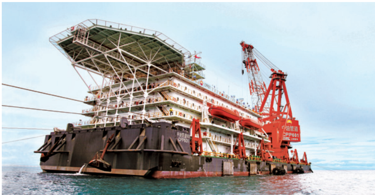
Работы CPP601 трубоукладочного судна
