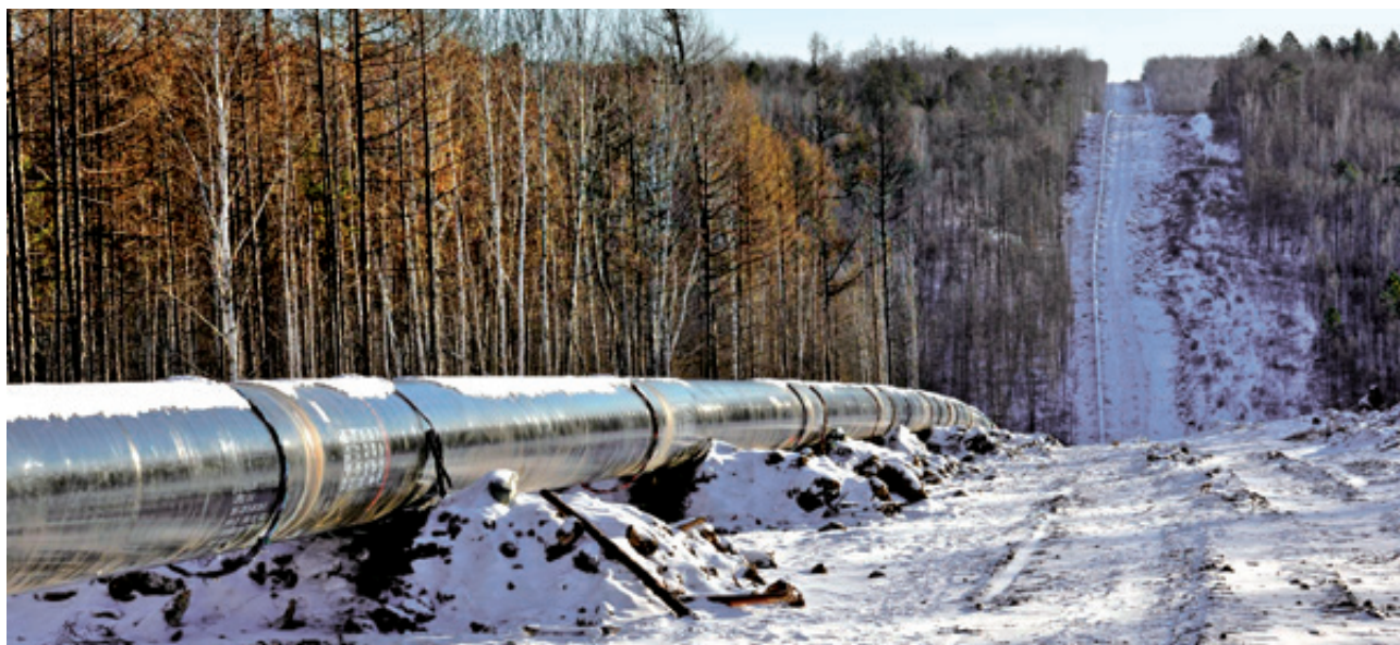
Строительство второй линии нефтепровода Россия-Китай
