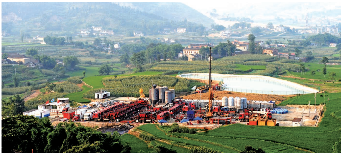
Работа по гидроразрыву с применением песка в блоке сланцевого газа Вэйюань в провинции Сычуань
