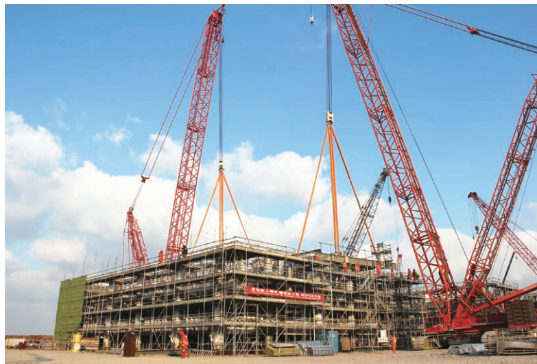
Строительство инженерингового комплекса MWP4 для проекта Ямал СПГ
