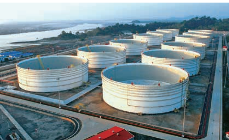
Construcción del almacén petrolero en la isla de Maday en Myanmar
