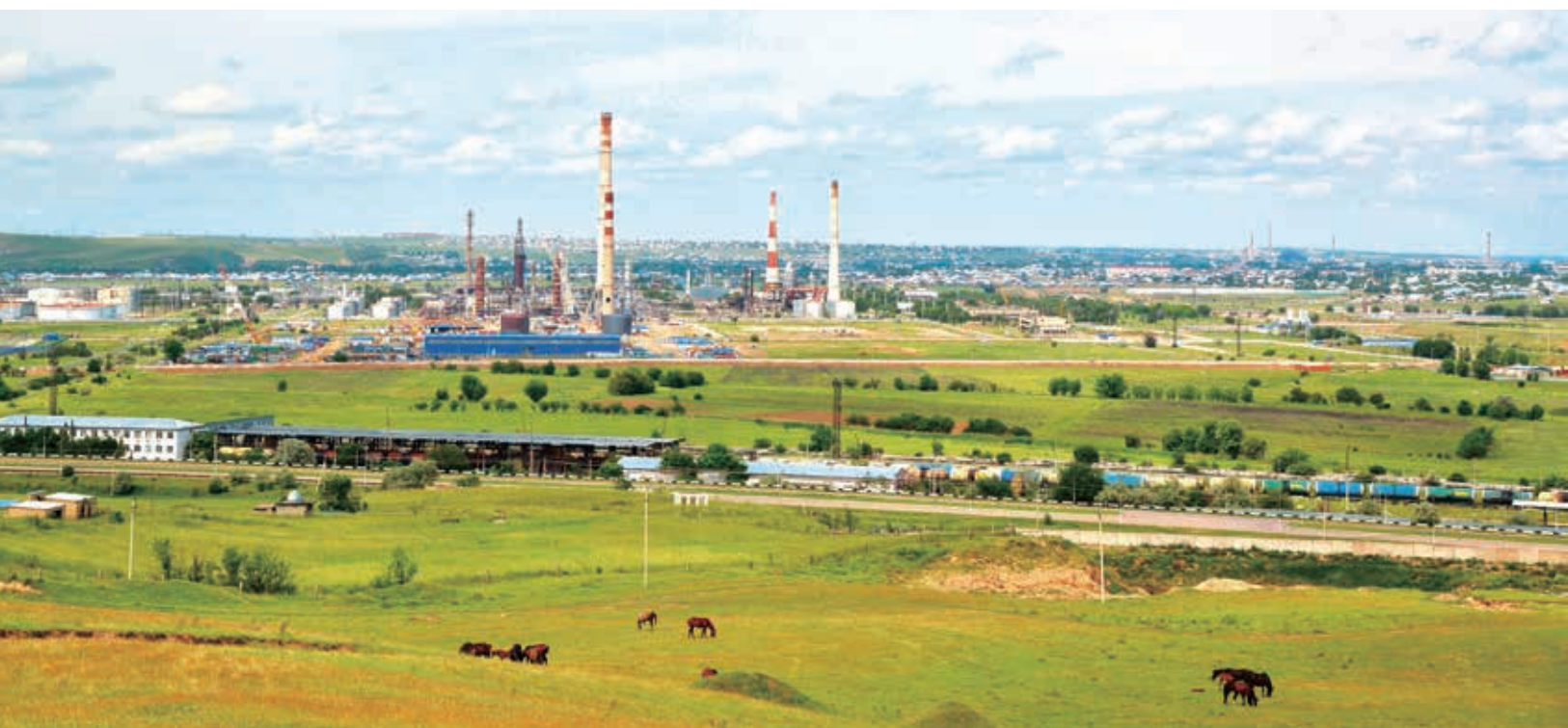
Refinería Shymkent en Kazajstán
