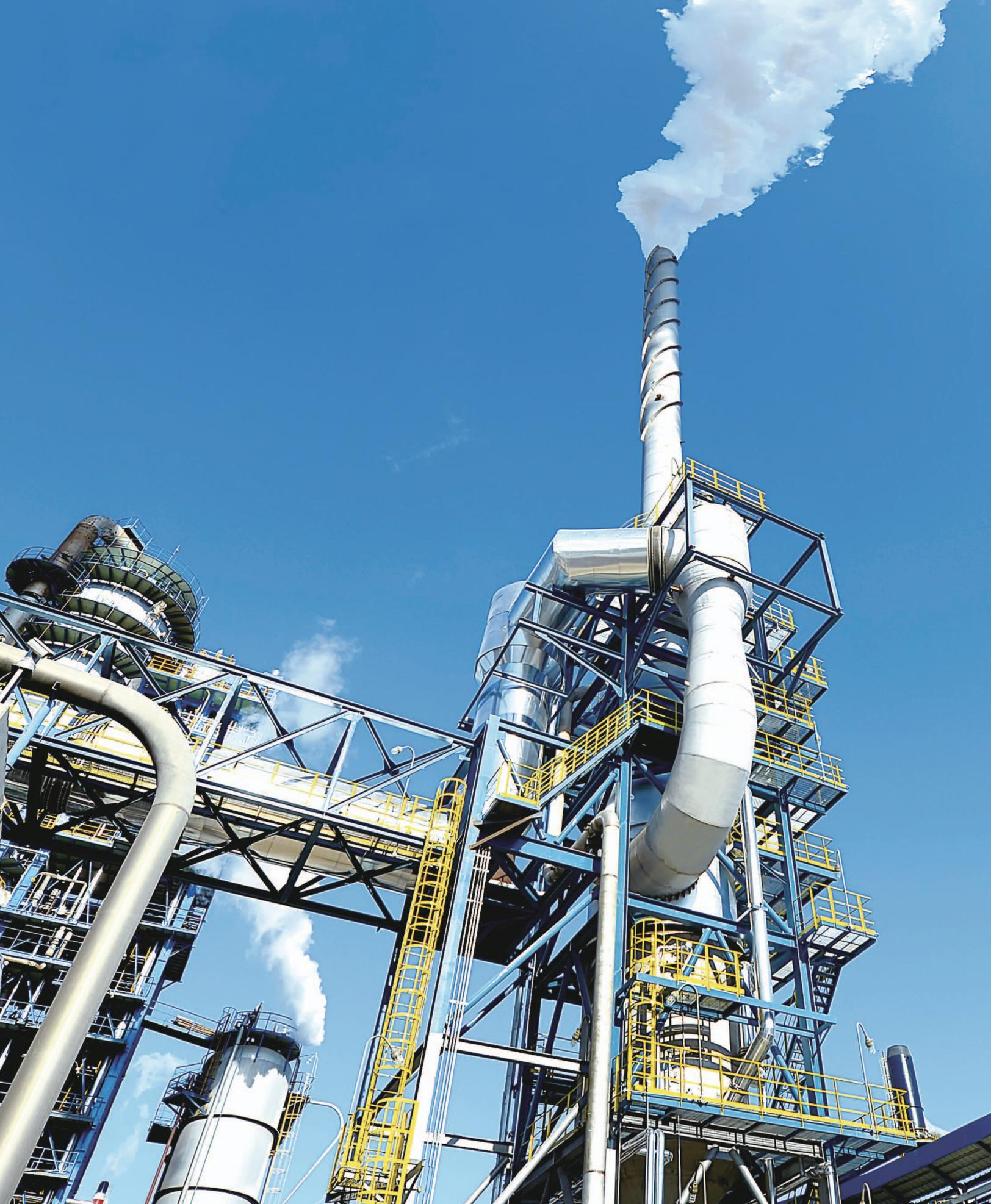
Instalación de depuración de gases de combustión en Jinxi Petroquímica
