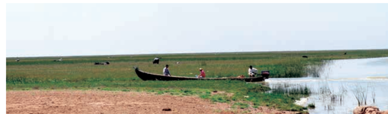
管线穿越后及时恢复地貌
