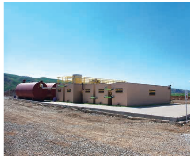
勘探项目营地实现污水零排放
