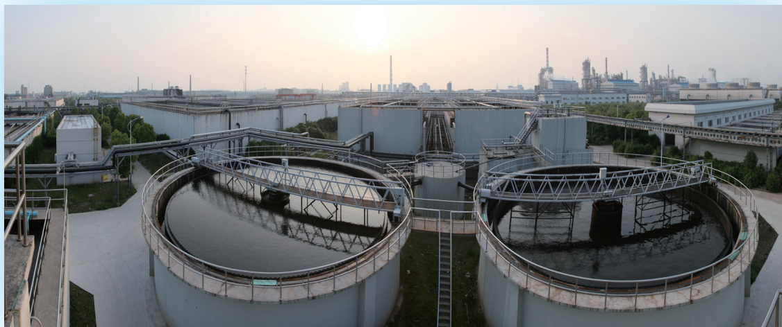
化工污水处理装置
