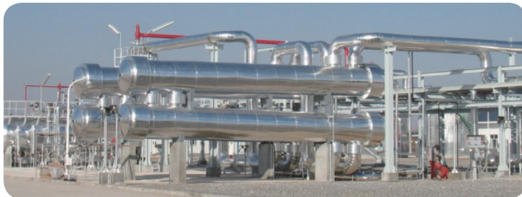
冷剂制冷脱水脱烃装置
