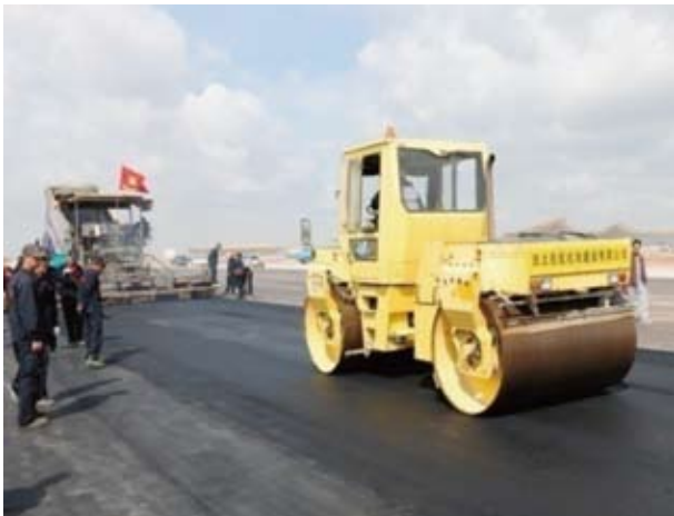
委内瑞拉超重油生产重交沥青应用现场
