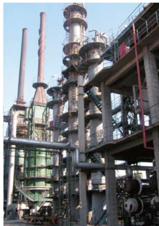
辽河石化 100 万吨 / 年装置
