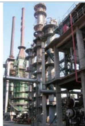
100 万吨 / 年供氢热裂化装置
