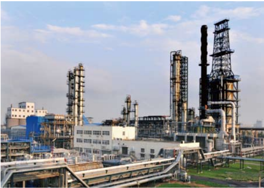
辽河石化 100 万吨 / 年延迟焦化装置
