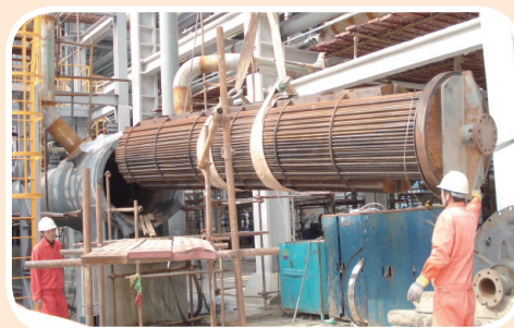
广西石化螺纹锁紧环 换热器现场检修
