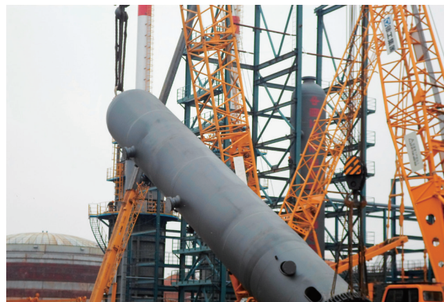
产品现场安装
