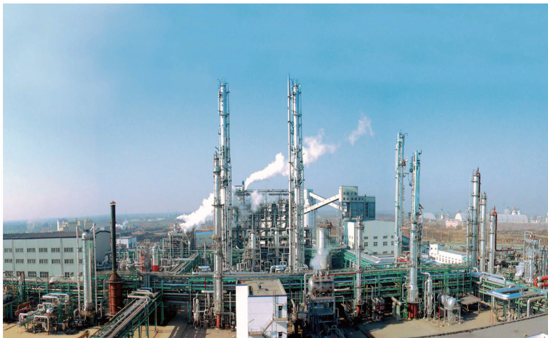
— 山东华鲁恒升大氮肥装置全景图 —
