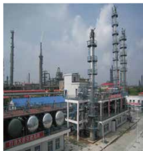
大庆石化 5000t/a 己烯-1 装置
