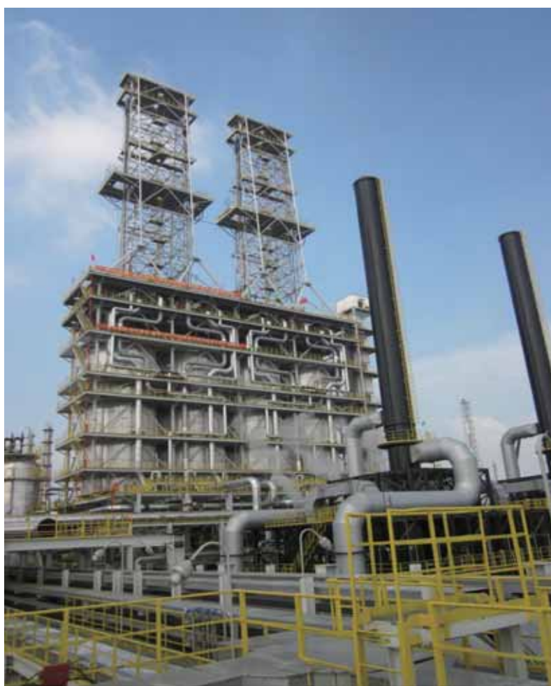
抚顺石化 240 \times 10^4 \text{t/a} 延迟焦化装置焦炭塔
