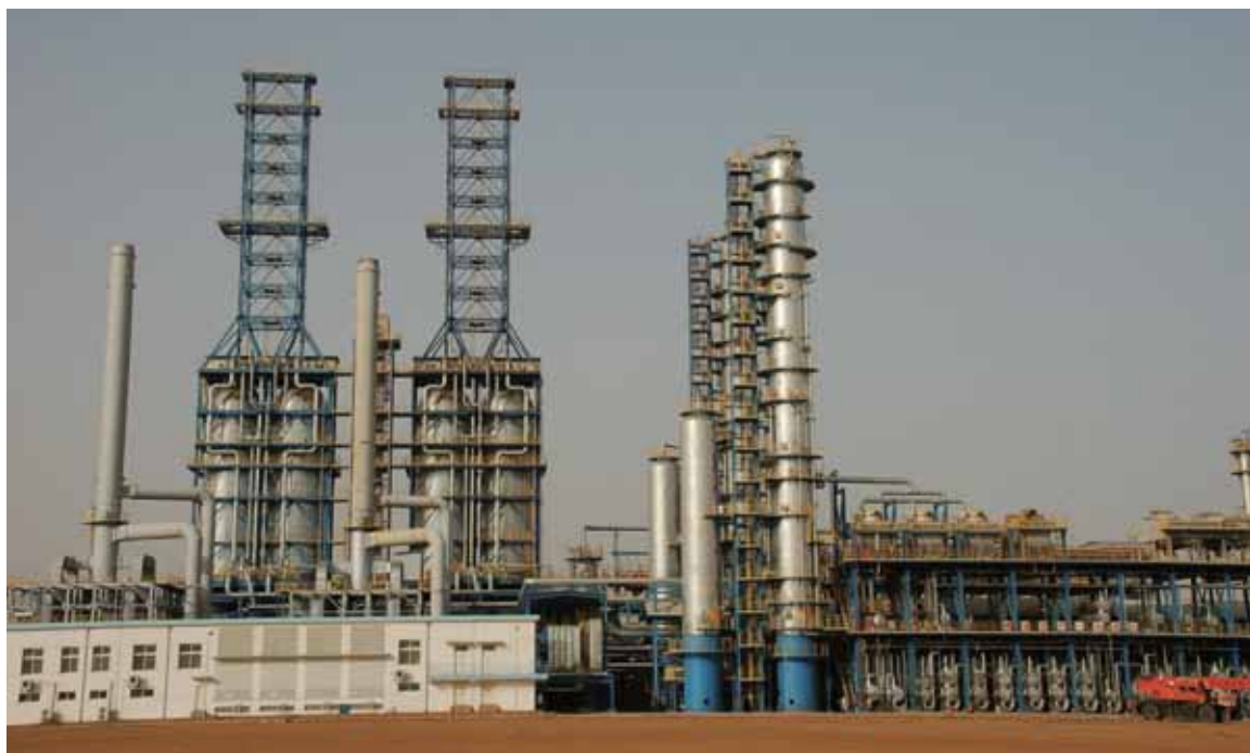
苏丹喀土穆炼厂 200 \times 10^4 \text{t/a} 高酸高钙原油延迟焦化装置
