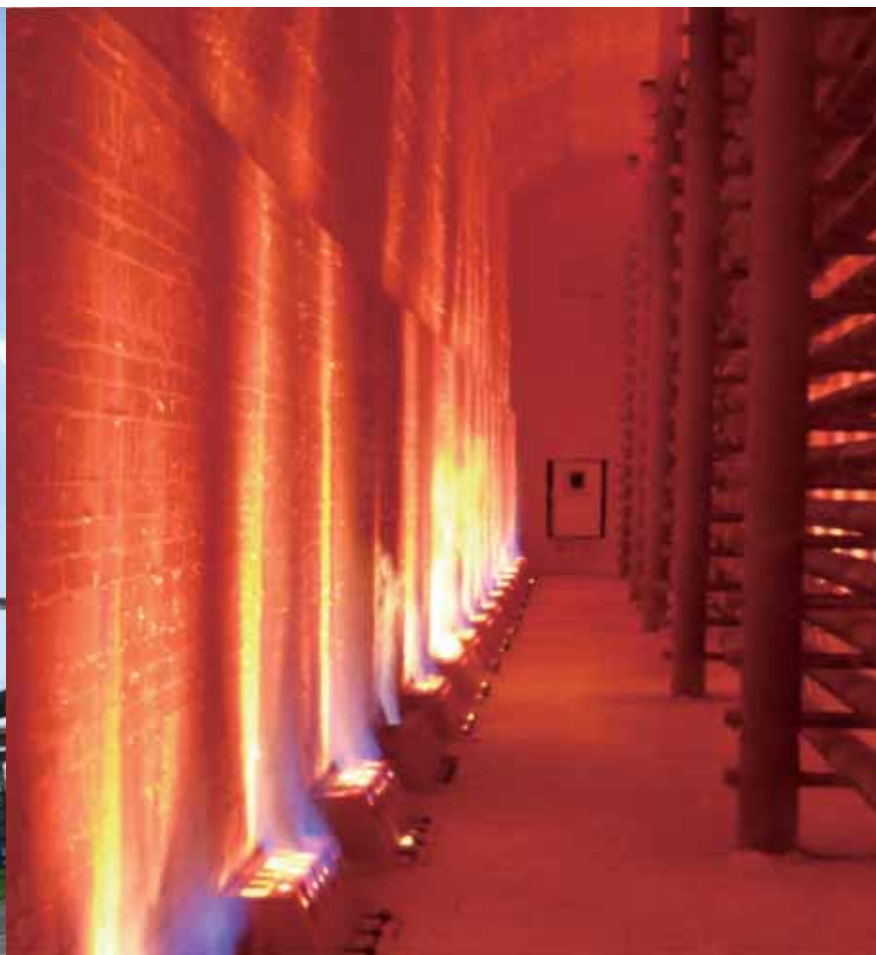
辽河石化 100X10 4 t/a 延迟焦化装置改造后的 “附墙燃烧技术”加热炉
