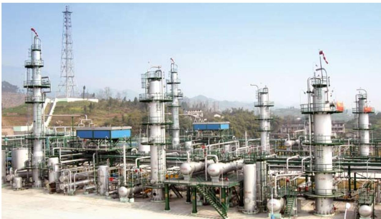
天然气净化厂（采用 CT8-5 选择性脱硫溶剂脱硫）
