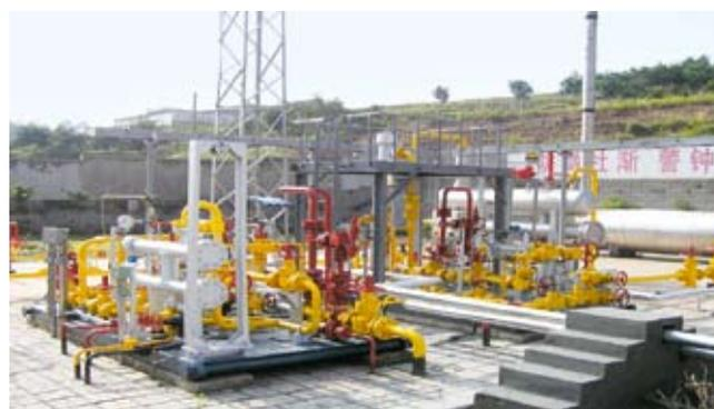
高含硫气田现场腐蚀试验装置
