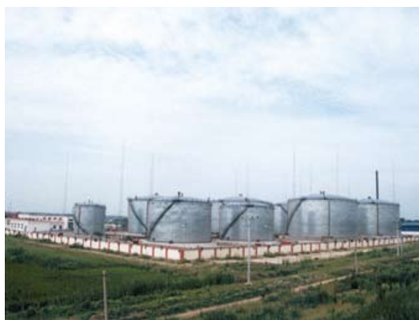
冷一原油集中处理站
