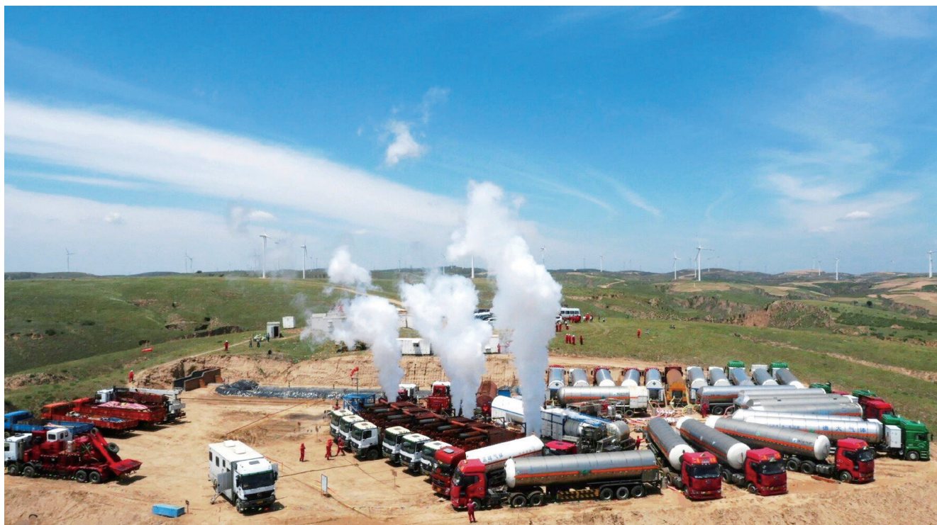
长庆苏里格气田施工现场图
