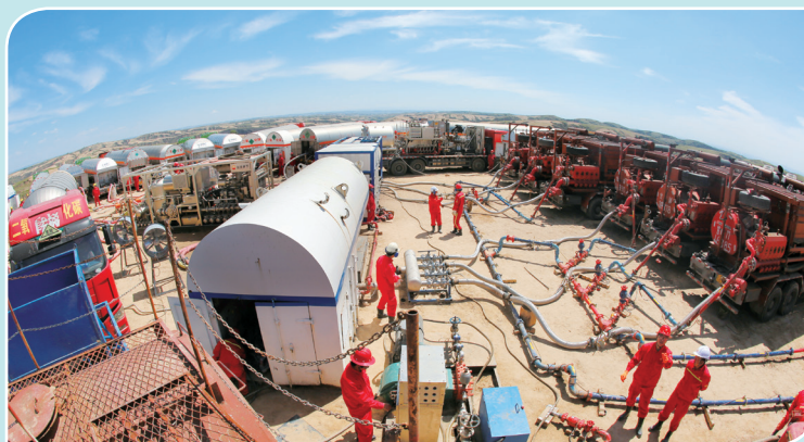
长庆神木气田施工现场图
