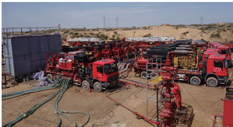
双 79 井套管滑套压裂施工现场
