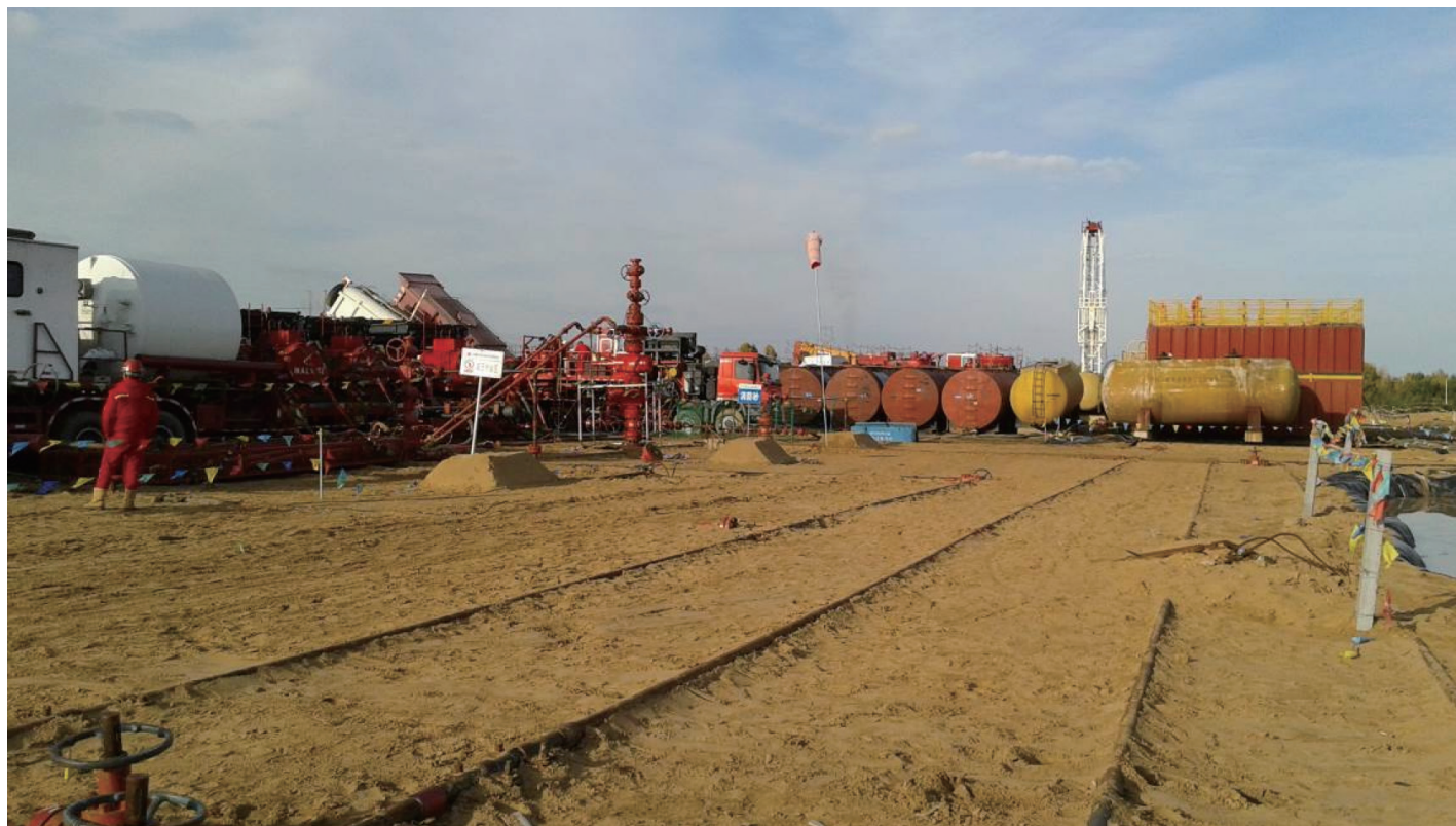
双平 42 井套管滑套压裂施工现场
