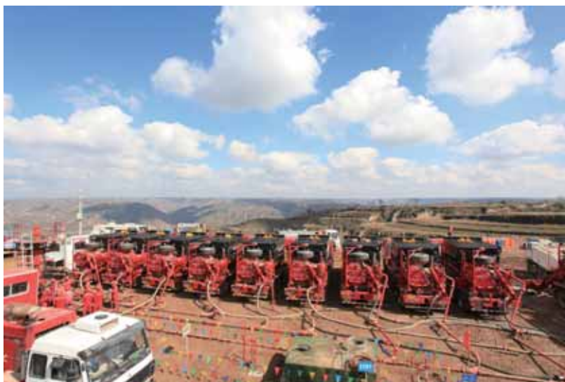
水力喷射压裂现场施工
