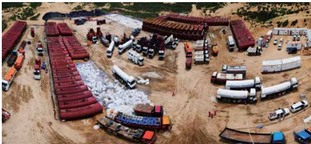
B 井水力喷射压裂施工现场（气田）
