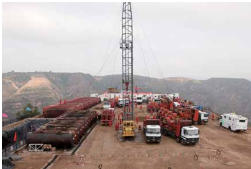
A 井水力喷射压裂施工现场（油田）
