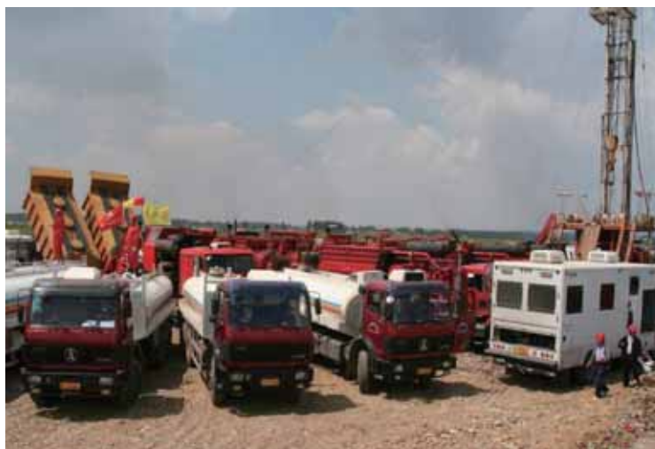
× × 井水力喷射压裂施工现场（吉林油田）
