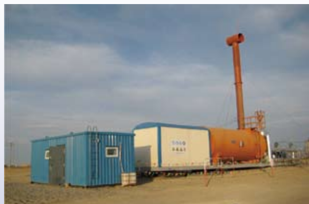
新疆油田稠油注过热蒸汽开采试验现场
