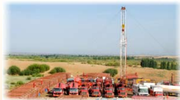
S75-70-6H 井现场施工作业
