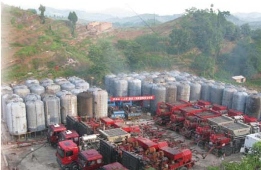
M030—H21 井现场施工作业
