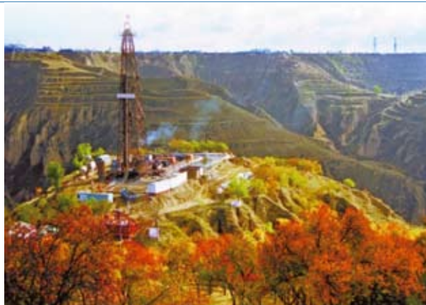
长庆油田开发压裂施工现场
