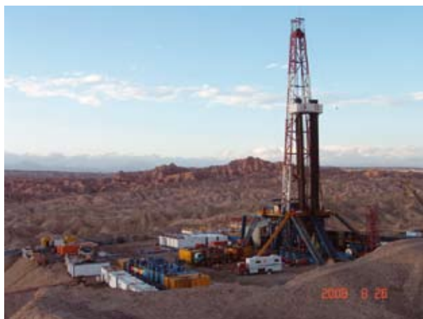
超低浓度羧甲基瓜胶压裂液施工现场
