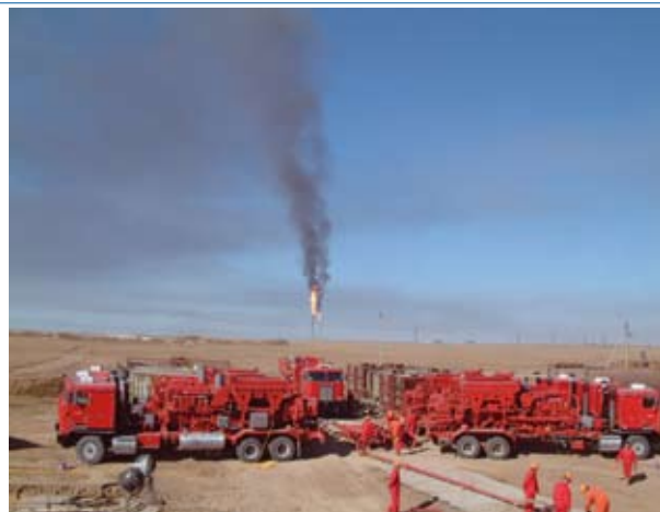
哈萨克斯坦分层酸压施工现场
