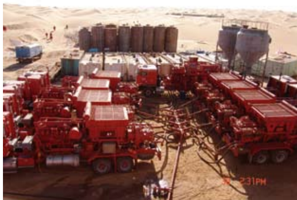
塔里木超深井压裂施工现场
