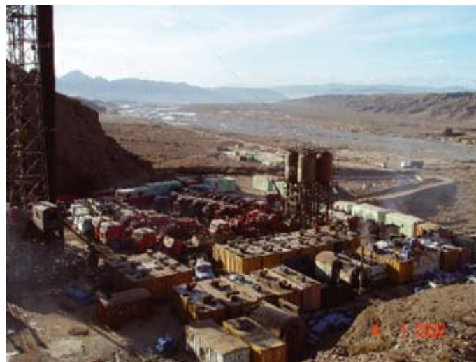
塔里木阿克 1 井压裂施工现场
