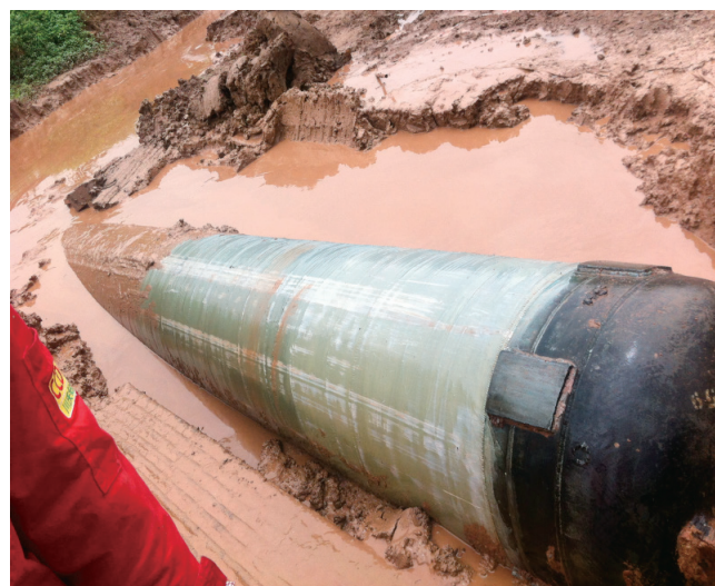
—— 定向钻穿越管道防腐层保护 ——
