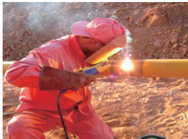
内衬 316L 复合管现场施工
