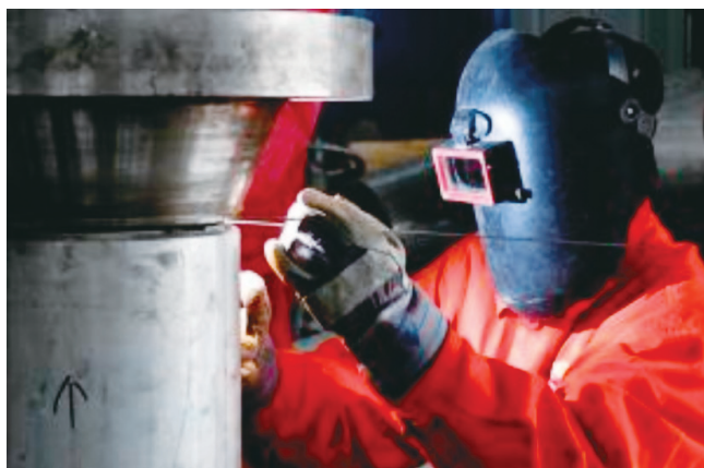
双相不锈钢管件焊接
