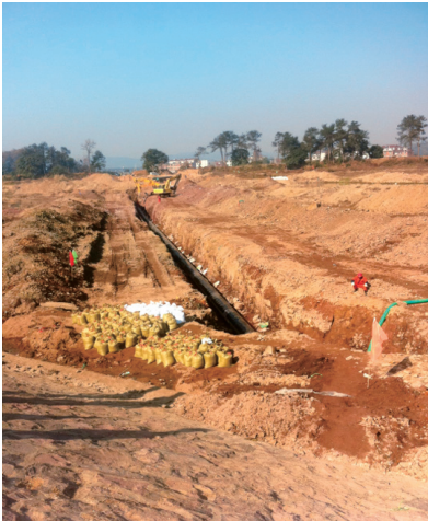
—— 直流干扰综合防护措施（锌带敷设） ——
