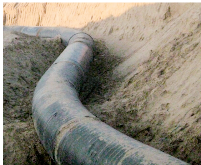
φ 1420 管道热煨弯管外防腐保护技术
