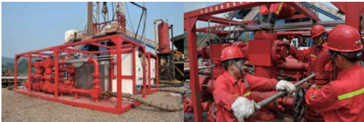
牛东 102 井控压钻井现场应用
