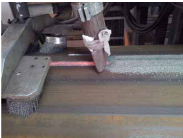
焊剂应用现场
