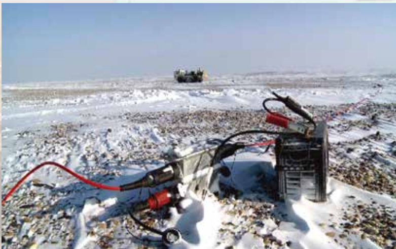
野外施工现场
