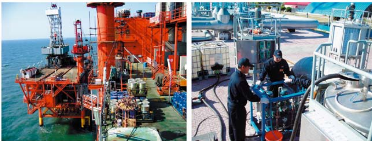
EP 管道助剂应用现场
