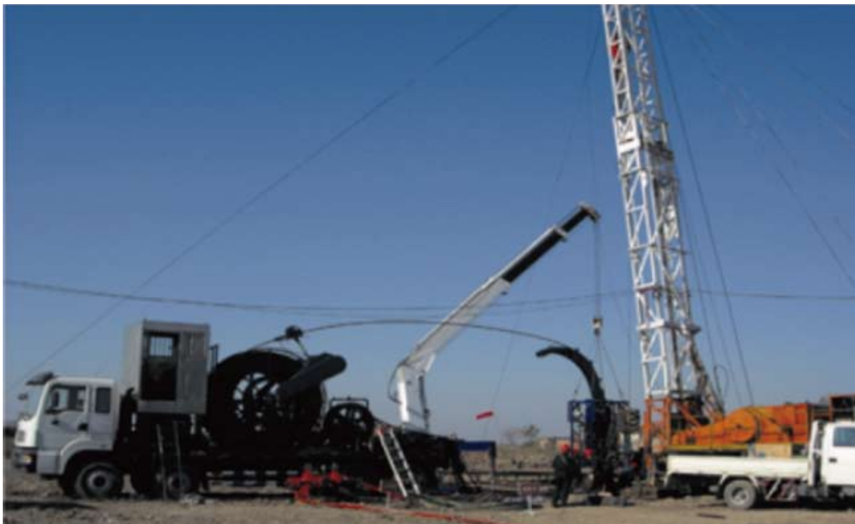
大港油田西 H1 井冲砂解堵作业
