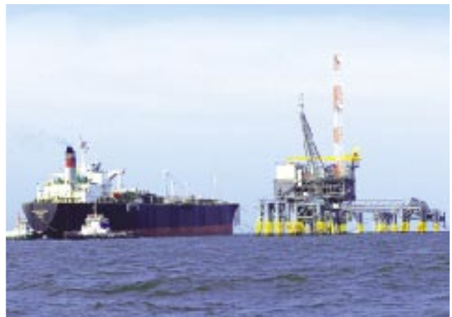
Terminal de la costa del proyecto LPG en Indonesia.
