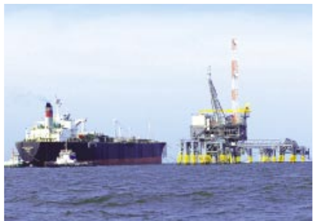
Terminal offshore du projet LPG en Indonésie
