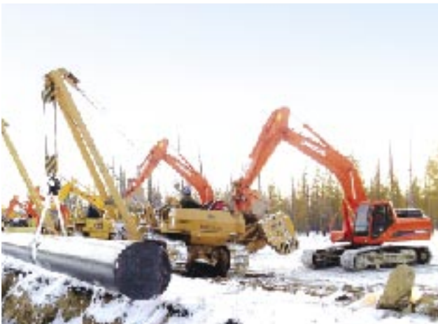
Travaux de construction de l'oléoduc en extrême-orient de la Russie
