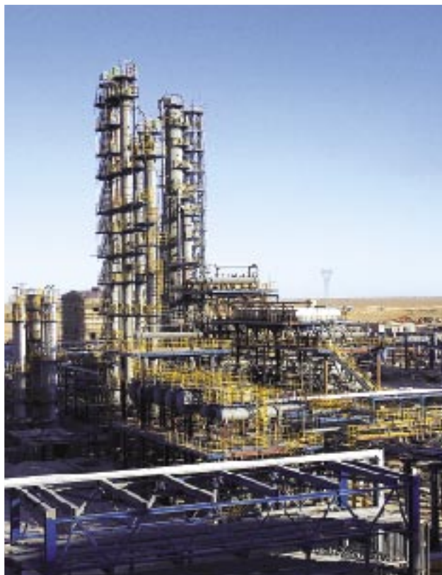
Installation intégrée de décomposition de gaz sous pression atmosphérique dans la Raffinerie d'Adrar en Algérie
