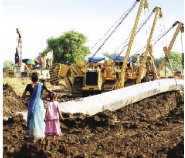
Travaux de construction de l'oléoduc Est-Ouest en Inde
