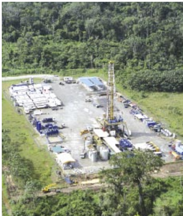
Chantier de forage du bloc TARAPOA d'Andes Petroleum Company en Équateur
