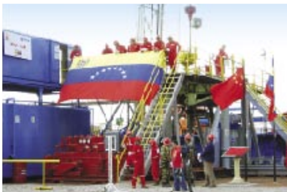
Chantier de forage du puits J4-05 au bloc 4 Junin sur la bande de pétrole lourd d'Orénoque au Venezuela
